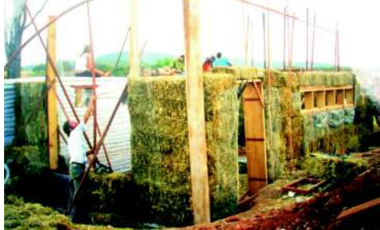
Figura 4: Elevação de paredes com fardos de palha e estrutura de madeira.
